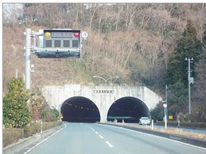
7 「相子島トンネル」です。 このトンネルを出たら続いてもう一つトンネルを通ります。
